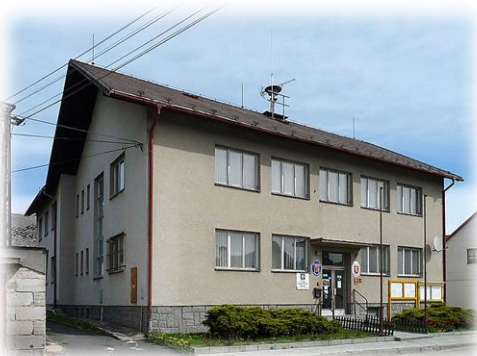
Budova úřadu městyse Kolinec – přízemí
